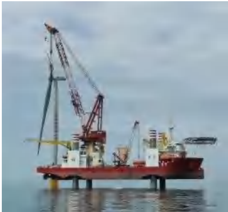
图 3.1.3-7 自升式平台船进行风机安装图示
