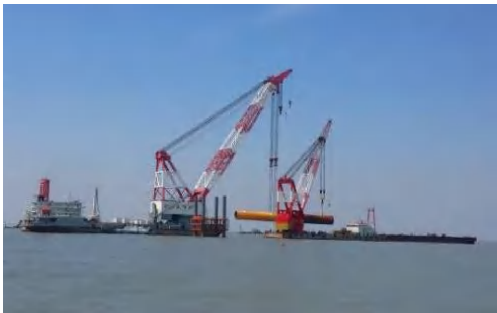
图 4.1.3-5 浮式起重船起吊钢管桩图
