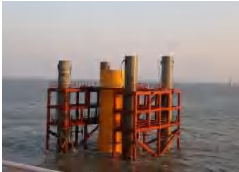
图 3.1.3-4 单桩定位架示意图
