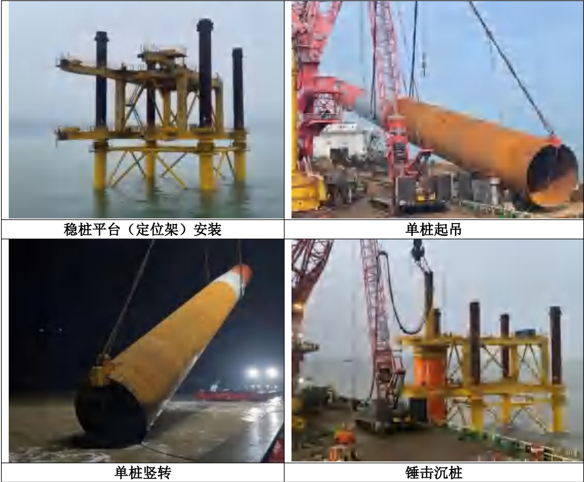
图 3.1.3-6 单桩基础施工图示
