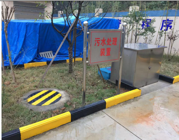
图 8.1 验收调查阶段升压站污水排放口
