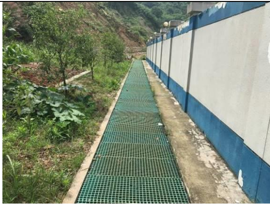
110kV 升压站东侧排水沟及绿化
