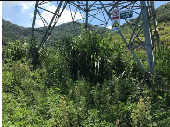
110kV 上网线路塔基植被恢复情况照片
