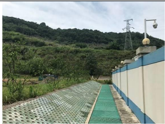
110kV 升压站南侧护坡及排水沟
