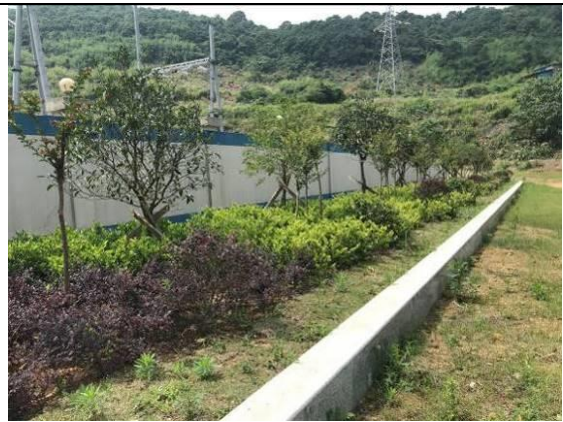
110kV 升压站北侧绿化
