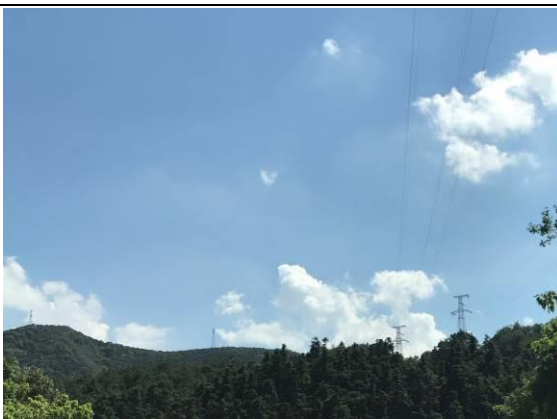
110kV 上网线路线路沿线照片
