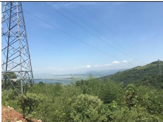
110kV 上网线路线路沿线照片
