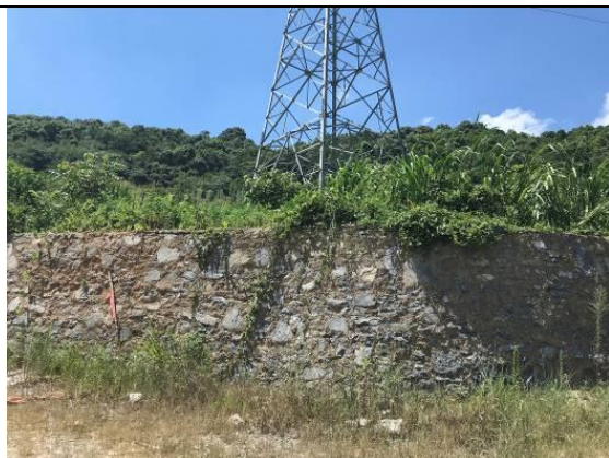
110kV 上网线路塔基护坡
